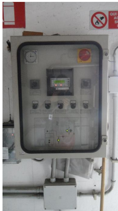
Figura 4.24 - Centralina climatica con cronotermostato.
