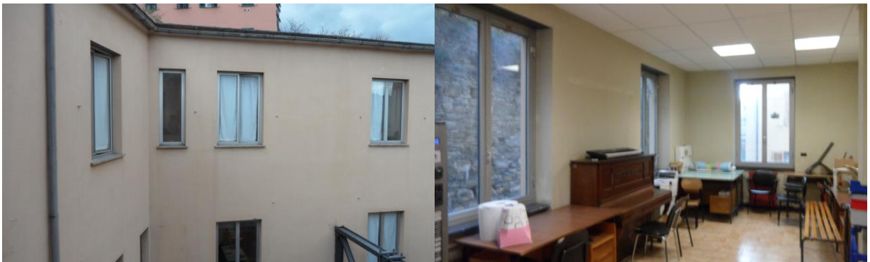
Figura 4.17 – Serramenti in alluminio e vetrocamera singolo
