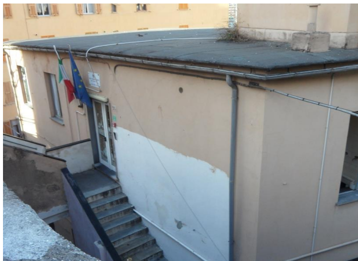
Figura 1.1 - Vista della facciata su salita di Oregina 26A
