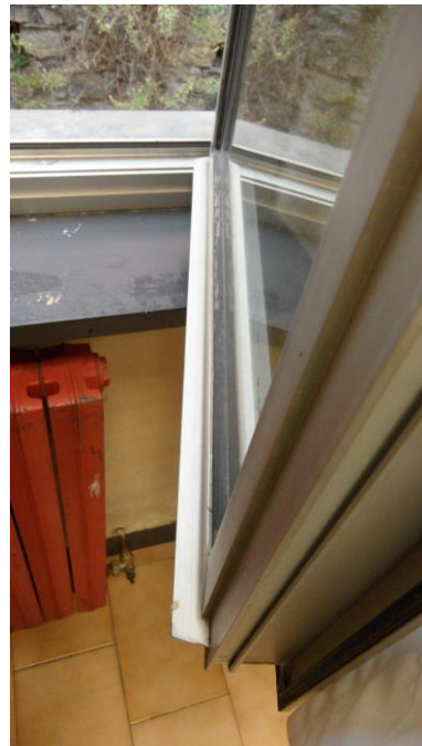
Figura 4.17 – Serramenti in alluminio e vetrocamera singolo
